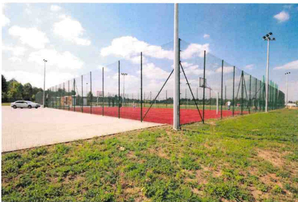
Zdj.17. Widok poglądowy ogrodzenia o wysokości 4,0 m.
